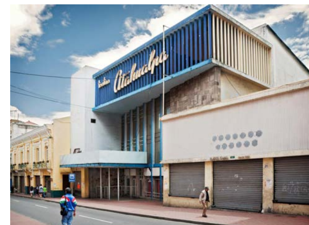
FIGURA 2.07 - Teatro Atahualpa, vista exterior
