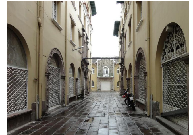
FIGURA 3.04 - Espacio abierto interior en el CHQ
