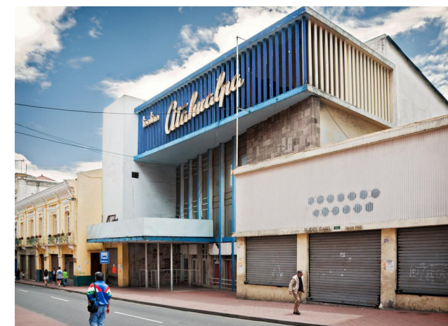
FIGURA 2.07 - Teatro Atahualpa, vista exterior
