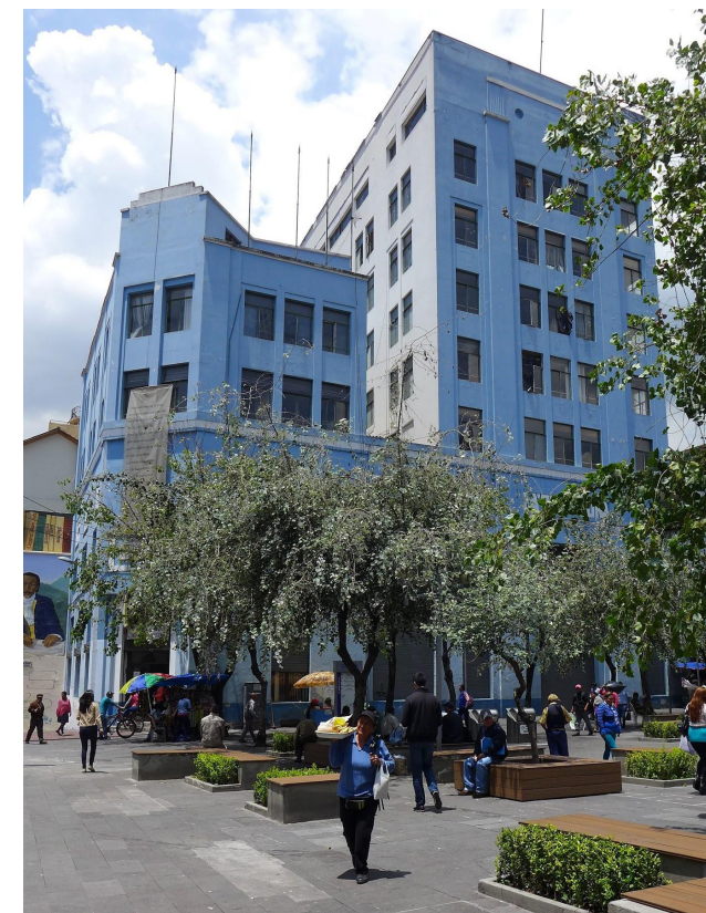
FIGURA 2.08 - Ex Hotel Humboldt | Edificio la Previsora y plaza pública exterior
