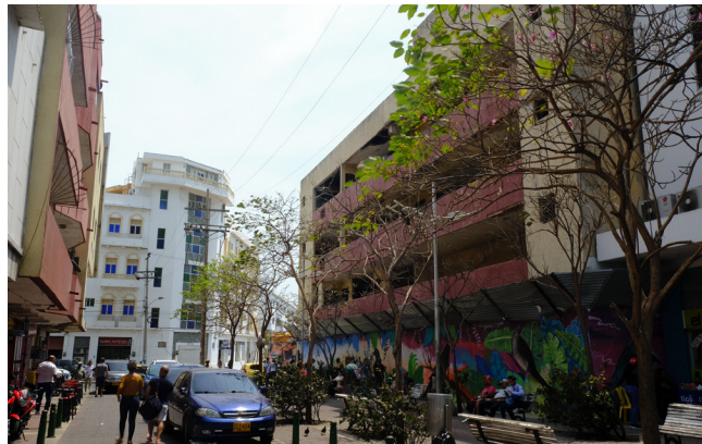
Figura 8.7 Ejemplo de edificio adecuado para una rehabilitación estratégica
