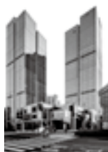
外滩国际金融服务中心 Bund International Financial Service Center
